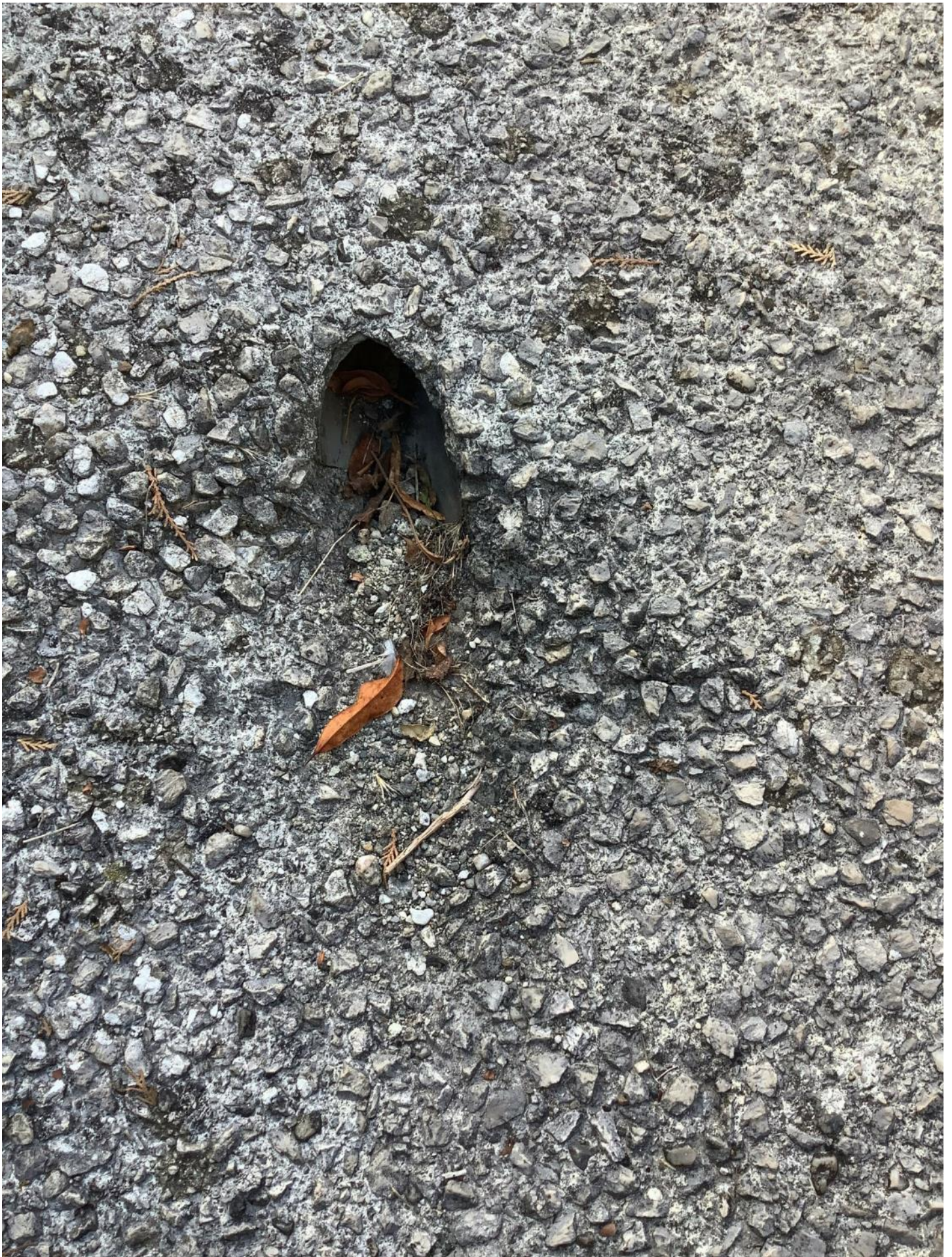
trou dans le sol par Alexandre
