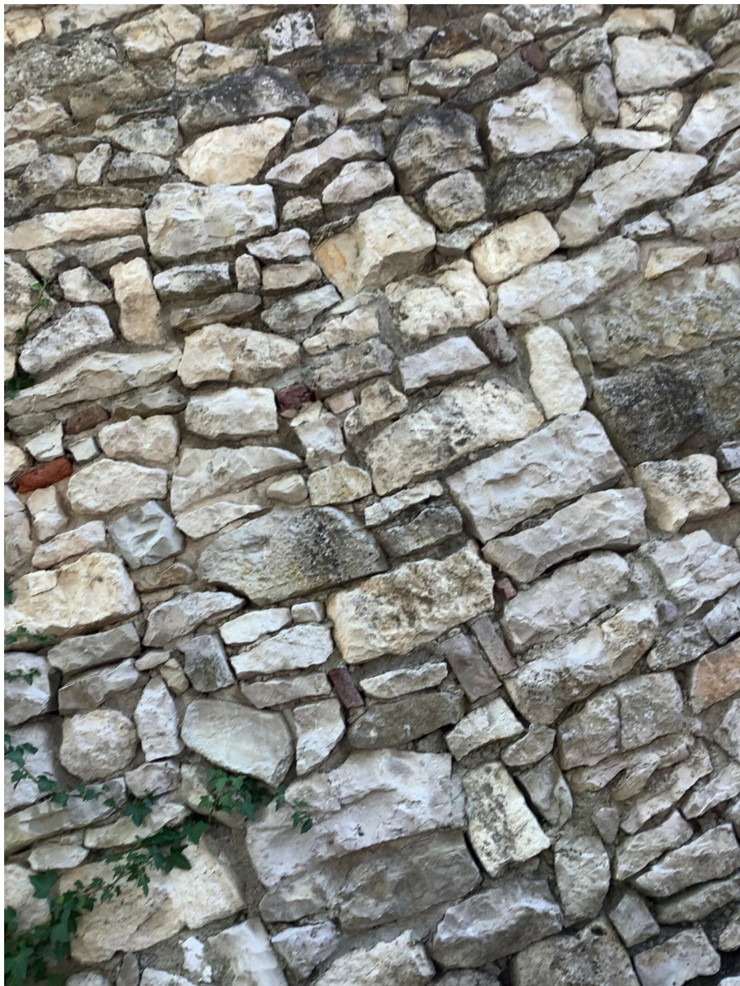
mur en pierre par Télio
